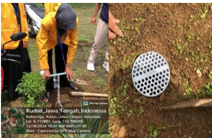
Gambar 4. Proses Pemasangan Biopori
